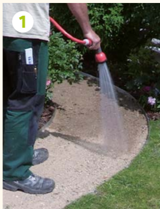
Schottertragschicht anfeuchten
