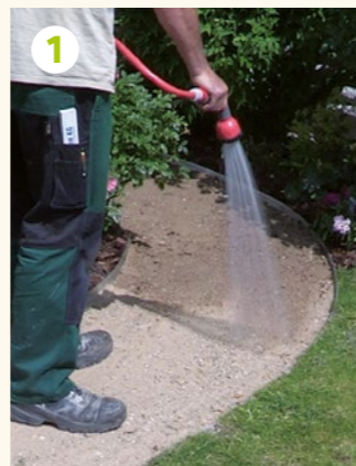
Schottertragschicht anfeuchten
